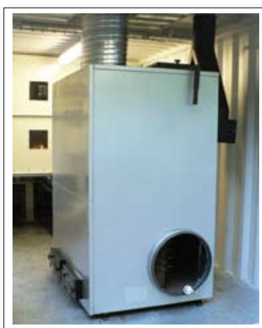
Pelletsmodul 50 kW
