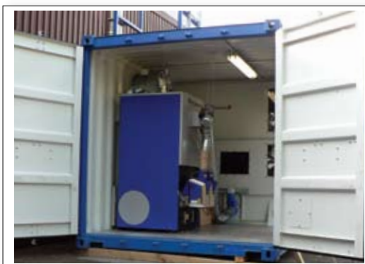
Pelletsmodul 50 kW
